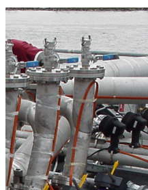
Установка системы электрообогрева на палубе танкера
